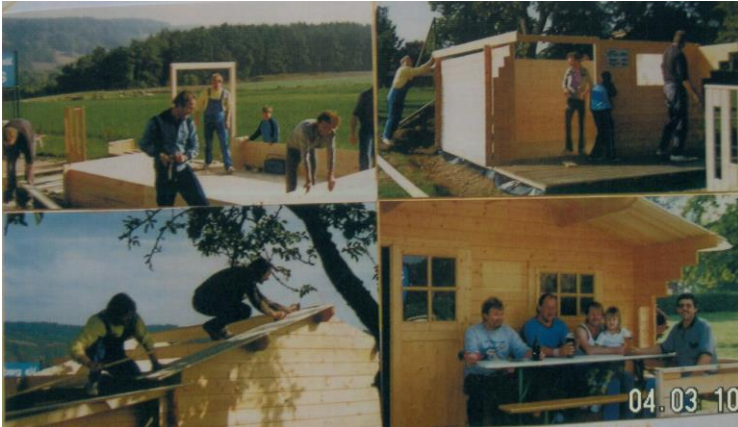
Mit viel Freude wurde 1990 dieses Blockhaus neben der Tennisanlage gebaut.
